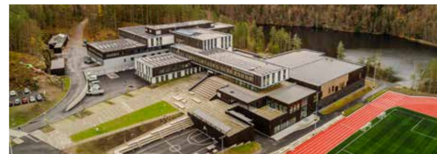
Den store solcelleparken på taket av Tvedestrand videregående skole dekker halvparten av takarealet. Noe av energien lagres i en batteripakke, og resten dekker løpende forbruk på skolen.
