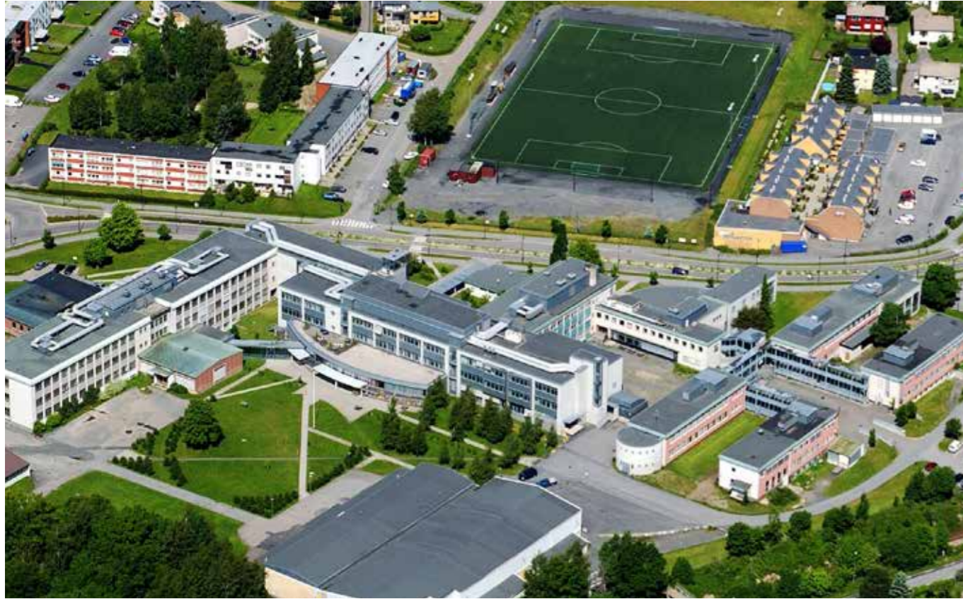
Sandefjord videregående skole har ca. 2 000 elever og 400 ansatte og skolebyggene har et samlet areale på 32 000m 2 . For tiden bygges det også tilbygg som ikke vises på bildet. (Foto: Olaf Akselsen)
